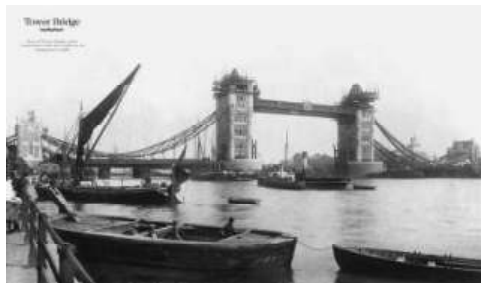
Будівництво Тауерського мосту, місто Лондон, фотограф невідомий, приблизно 1893 р.
