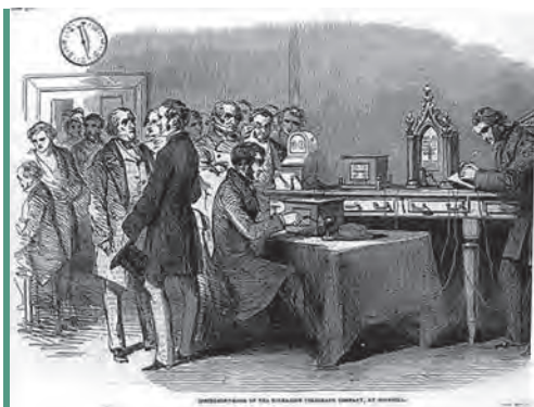
Невідомий художник. Отримання першого повідомлення Submarine Telegraph Company в Лондоні з Парижа за допомогою приладу Foy-Breguet у 1851 р. Обладнання на задньому плані — установка Кука — Уїтстона для подальшого передавання інформації. 1852 р.
