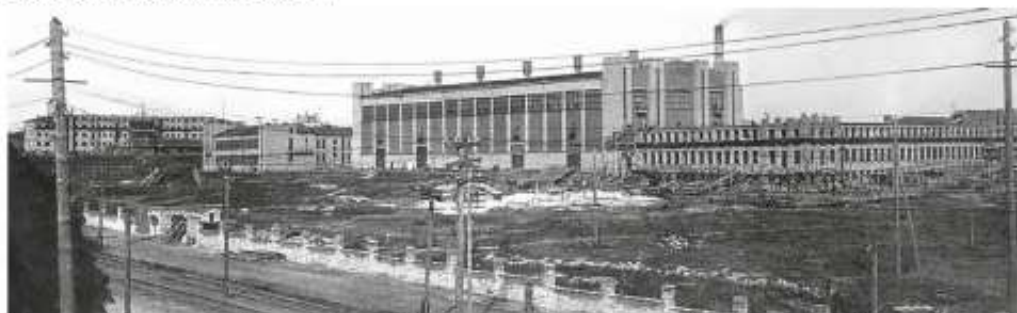
Кіностудія художніх фільмів ім. О. Довженка в Києві на етапі будівництва, 1927–1930 рр.
