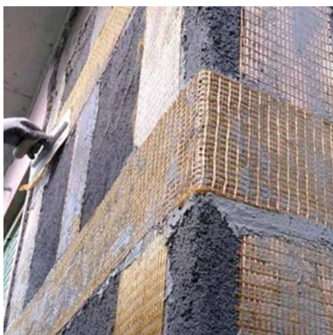
Мал. 146. Армування перекриття і стін на будівництві
