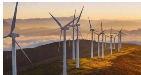
Мал. 159. Лопаті вітрових турбін — це одні з найбільших монолітних конструкцій у світі, що створені з композитів
