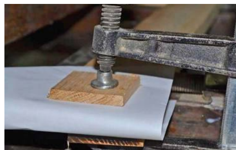
Мал. 86. Фіксація з'єднання струбциною
