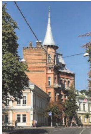
Прибутковий будинок. Київ, вул. Ярославів Вал
