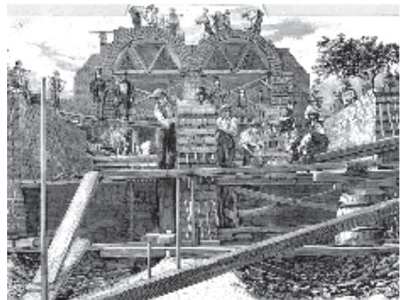
Будівництво колекторів біля Олдфорда (Східний Лондон), 1859 р.
