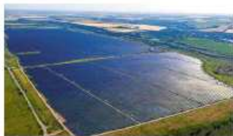
Мал. 75. Нікопольська СЕС, одна з найбільших сонячних електростанцій у Європі
