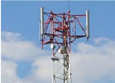
Мал. 18.3. Базова станція стільникового зв'язку
