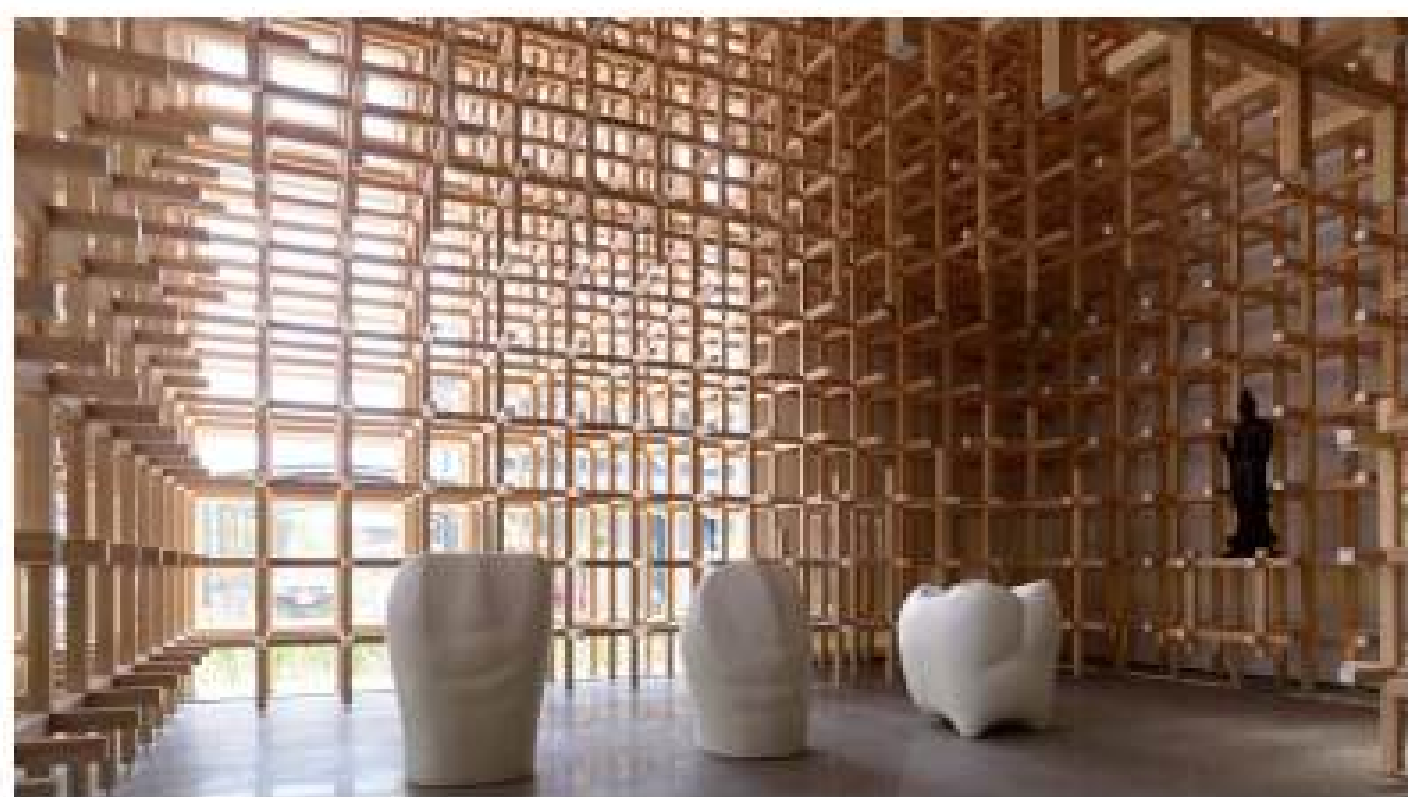
Мал. 93. Будівля, виготовлена з тисячі дерев'яних брусків, складених як гігантський 3D-пазл
