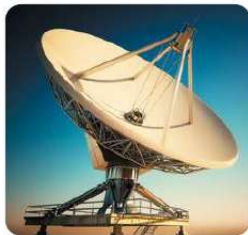
Рис. 13.16. Радіотелескопи містять великі тарілки для збору радіохвиль
