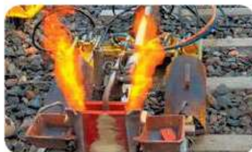
Рис. 6.2. Унаслідок хімічної реакції між ферум(III) оксидом та алюмінієм виділяється багато теплоти
