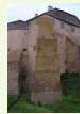
Мурована вежа Острозького замку. Світлина
