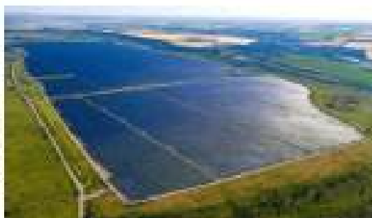
Мал. 226. Сонячна електростанція (м. Нікополь 2019 рік)
