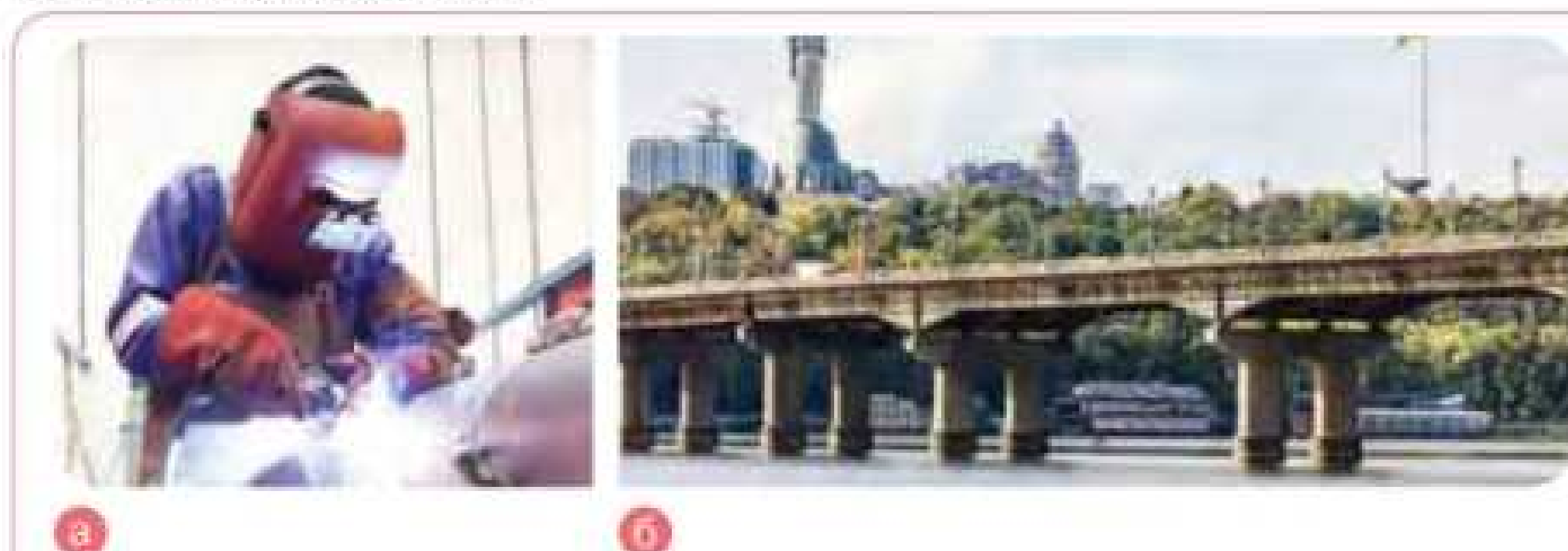
Мал. 30.4. Використання теплової дії струму під час контактного зварювання металів (а), міст Патона в Києві — перший у світі суцільнозварний міст завдовжки 1543 метри (б)
