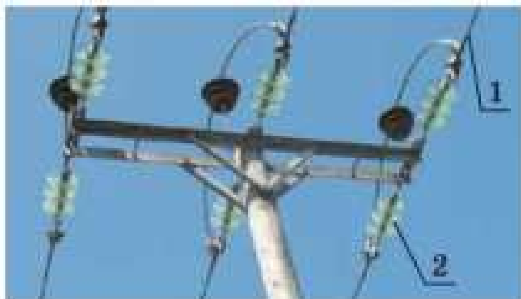
Рис. 31.2. Створення ліній електропередавання неможливе без використання провідників (1) і діелектриків (2)
