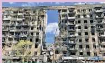
Загроза руйнування будівель
