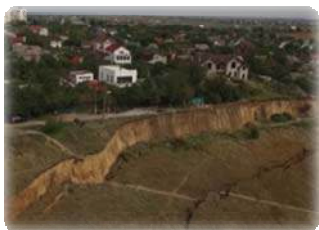
Зсув ґрунту в Одесі
