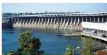
Дніпрогес Дніпровська гідроелектростанція
