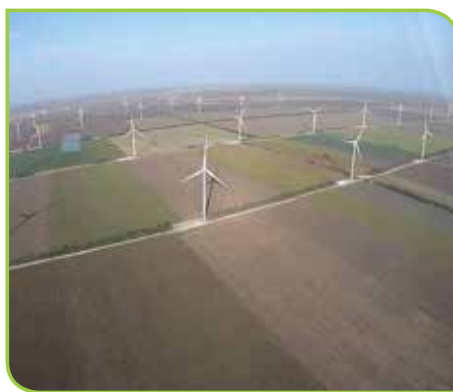
Ботіївська вітрова електростанція
