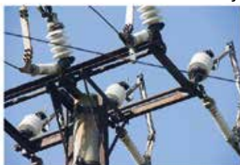
На лініях електропередач використовують порцелянові й скляні електроізолятори
