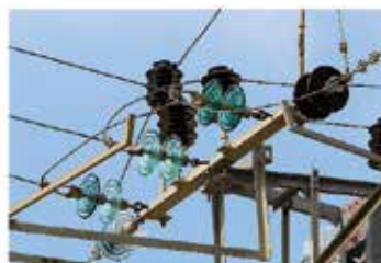
На лініях електропередач використовують порцелянові й скляні електроізолятори
