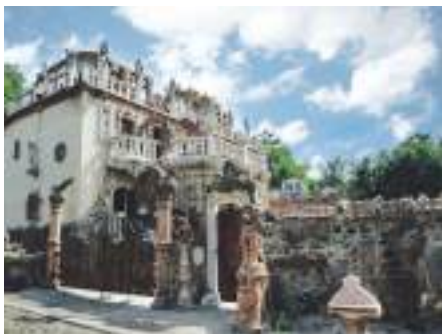
Будинок Голованя. Луцьк
