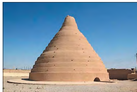
Якхчаль — башта для зберігання продуктів у спекотному кліматі, яку придумали в Давній Персії. Завдяки спеціальній конструкції тепле повітря в ній піднімалося вгору, а прохолодне залишалося внизу.
