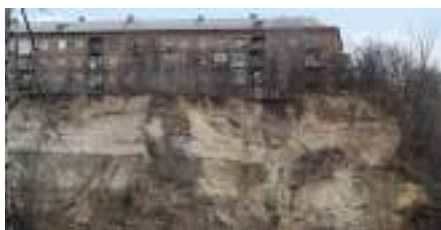
Мал. 69. Зсув ґрунту в Києві
