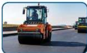
У будівництві доріг
