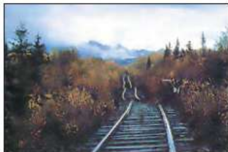
Мал. 6. Викривлення залізничної колії в результаті танення верхнього шару багаторічної мерзлоти.
