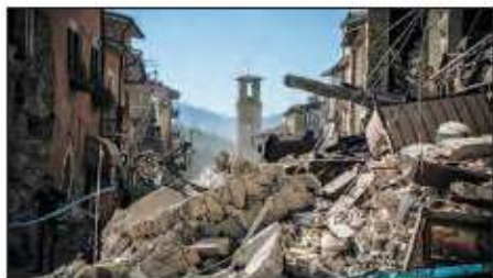
Мал. 3. Наслідки руйнівного землетрусу в центральній частині Італії (2016 р.).
