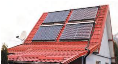
Мал. 46.2. Сонячне тепло нагріває воду в спеціальних трубках. Будинок забезпечений теплою водою
