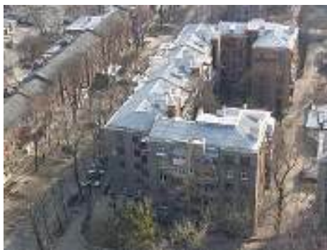
Будинок «Слово» (м. Харків, вул. Культури, 9)
