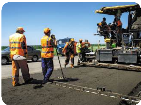
Ремонт дорожнього полотна
