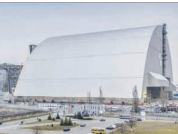
Арка безпеки над 4-м енергоблоком. 2016 р.
