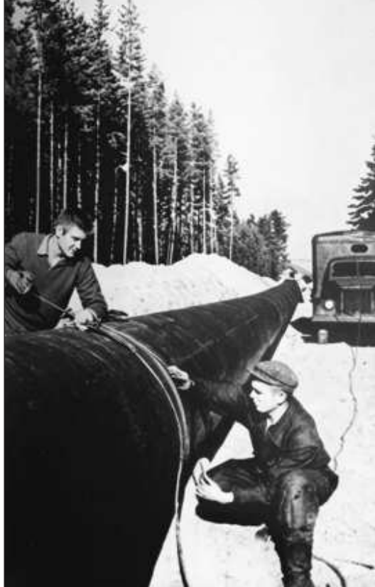
Будівництво газопроводу «Шебелинка—Острог». 1960 р.
