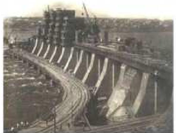
Будівництво Дніпрогесу. 1930 рік
